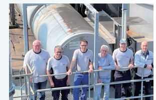
Regenerative thermal oxidizers (RTO)
