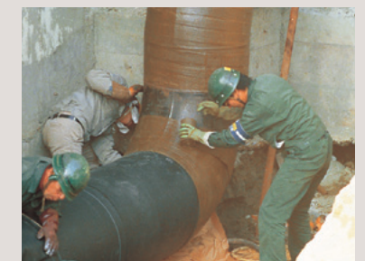
●冷却水用埋設鋼管の防食
