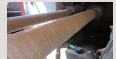
●ピット内配管の防食
