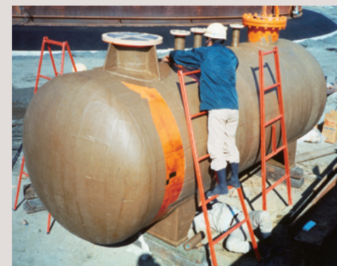
●埋設タンクの外面防食
