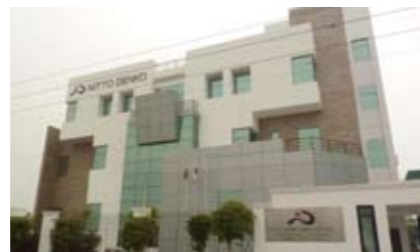
2009年11月に設立した日東電インドの建物
