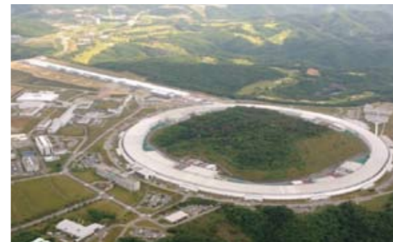
大型放射光施設（SPring-8）の全景 写真提供：SPring-8
