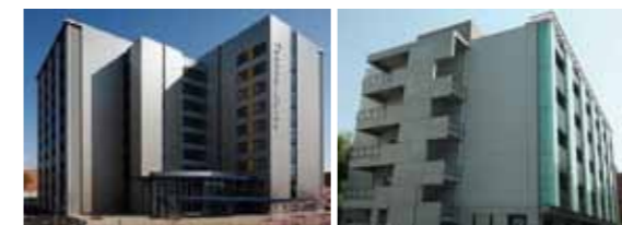
大阪大学テクノアライアンス棟
