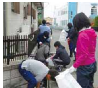
側溝の清掃。 津波のヘドロが溜ったままに なっており、除去した。
