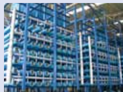
海水淡水化スパイラル型RO膜
