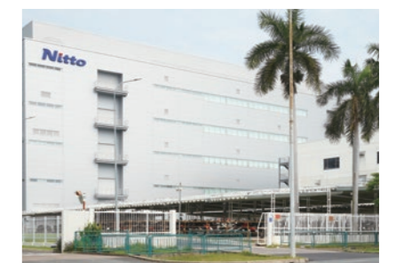
ベトナム工場(新築)
