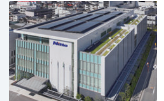
屋上に設置された太陽光発電設備
